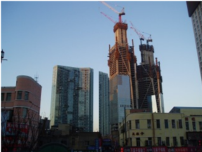
【高層ビル建築により都市化が進む大連市の様子】
