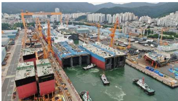
大宇造船海洋 玉浦造船所1ドック 写真左奥:ゴリアテガントリークレーン 出典:大宇造船海洋HP
