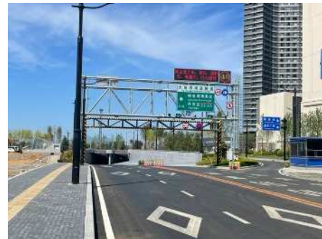
大連湾海底道路の入口
